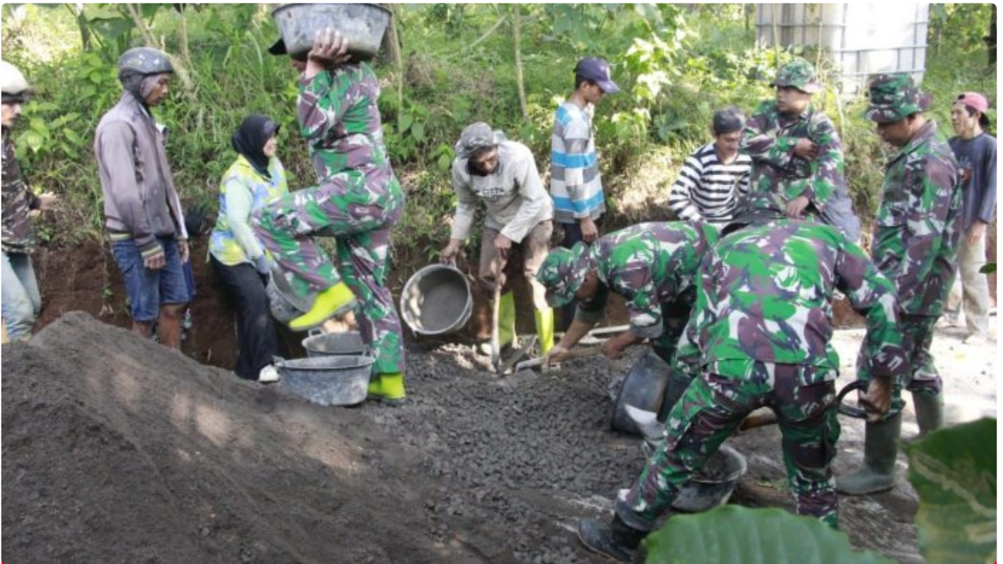
Warga Dan Satgas TMMD Bahu Membahu Kebut Pengerjaan sasaran Pengecoran Jalan
